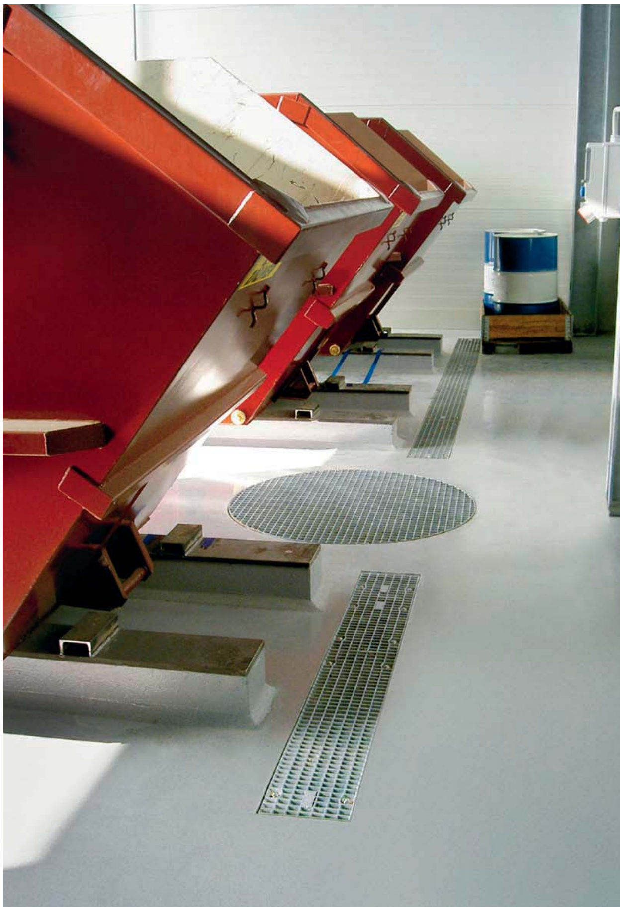
BIRCO pomproulatie met lekkage bewaking en 2-zijdige gotenaansluiting aan de BIRCOdicht.
