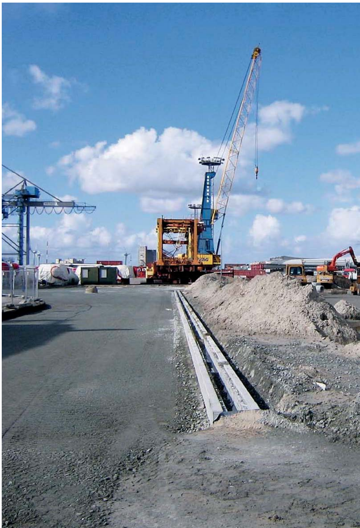
BIRCOsolid Roostergoot tijdens bouwwerkzaamheden bij de Noordbaai in Emden.
