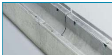
1. Gotengroef aan mes - voorafgaand aan het voegen
