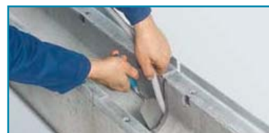
3. Aanbrengen van het PE-dichtsnoer
