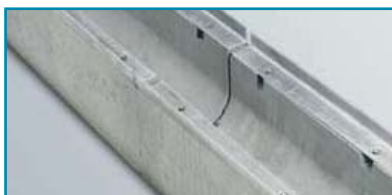
1. Gotengroef aan mes - voorafgaand aan het voegen
