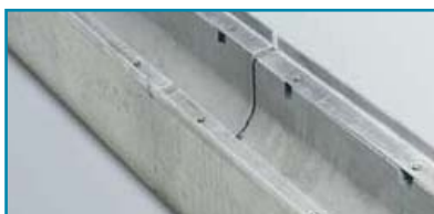
1. Gotengroef aan mes - voorafgaand aan het voegen
