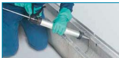
5. Aanbrengen van de voegstof
