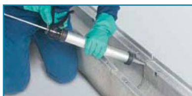
5. Aanbrengen van de voegstof
