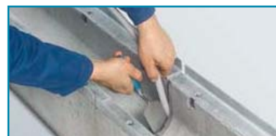
3. Aanbrengen van het PE-dichtsnoer
