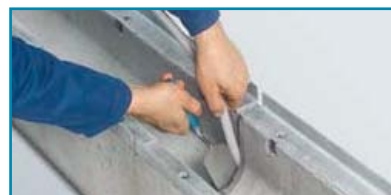
3. Aanbrengen van het PE-dichtsnoer
