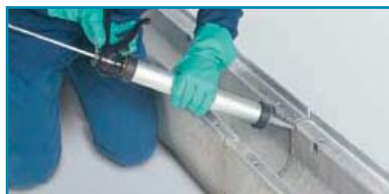
5. Aanbrengen van de voegstof
