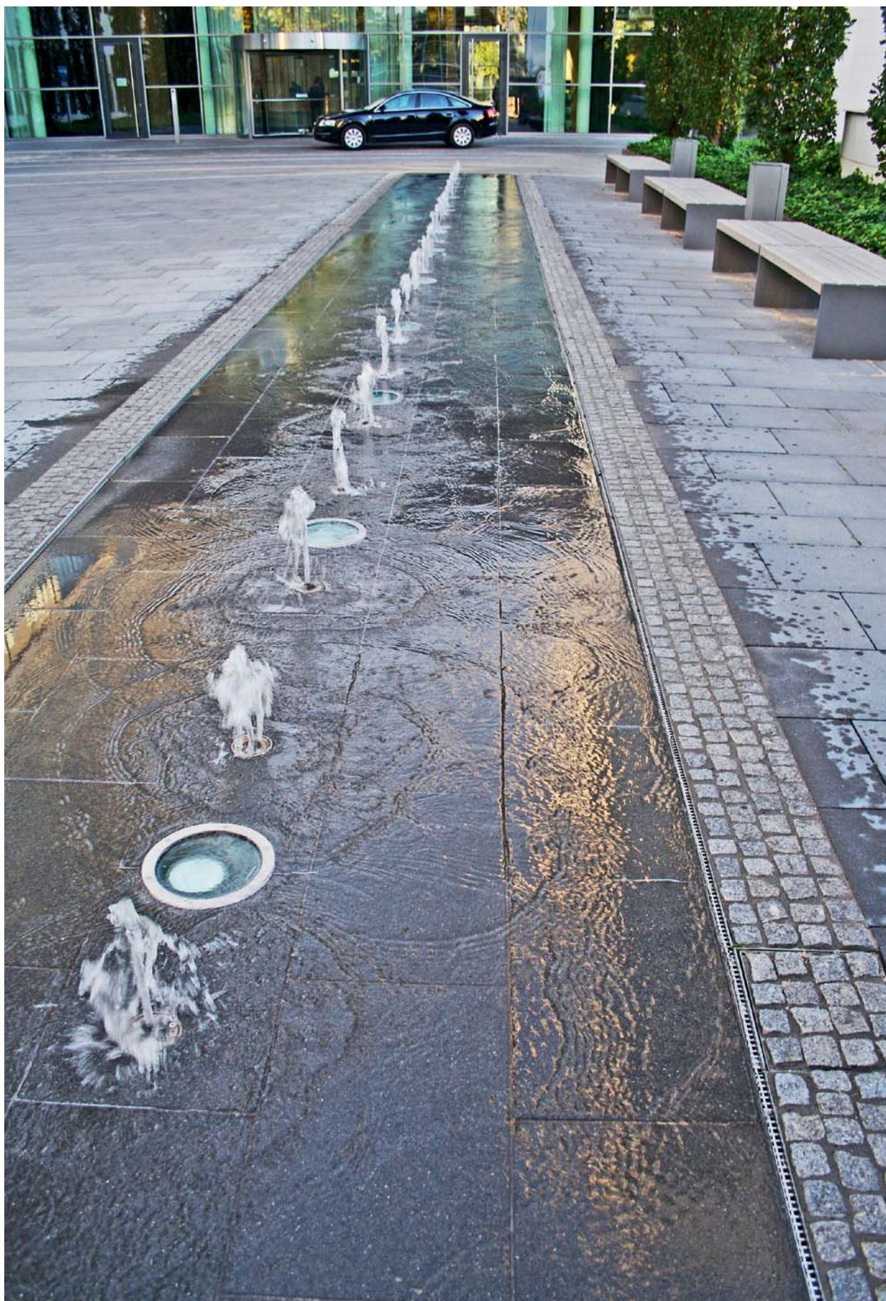
Aan de rand van de fontein wordt het water voor hergebruik afgevoerd in de goten van BIRCOtop Serie S.
