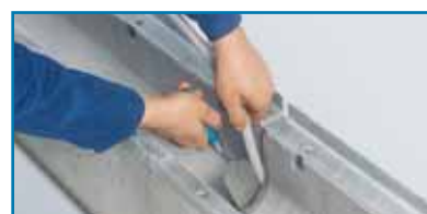
3. Aanbrengen van het PE-dichtsnoer
