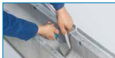
3. Aanbrengen van het PE-dichtsnoer
