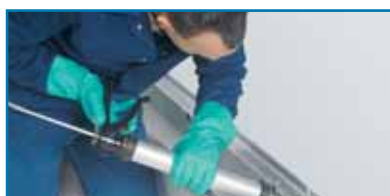
5. Aanbrengen van de voegstof
