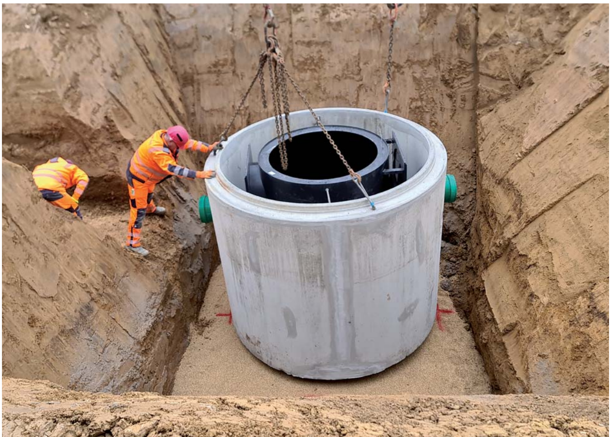
Installatie BIRCOhydroshark
